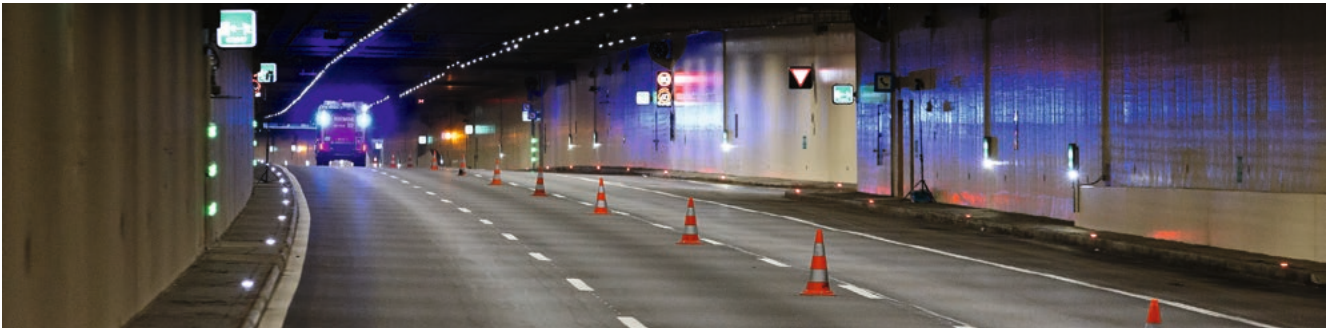
Durch den Kaisermühlentunnel führt auf 2.150 m Länge eine vierspurige Fahrbahn. Bild: ECOexperts, Österreich
